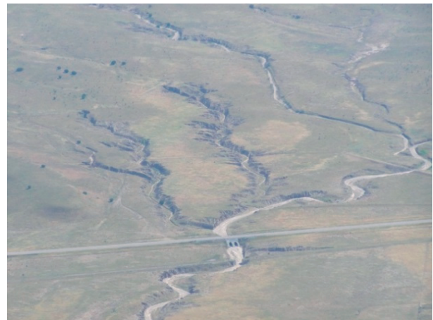
FIGURA 4. Ducto de drenaje demasiado profundo genera erosión aguas arriba.
